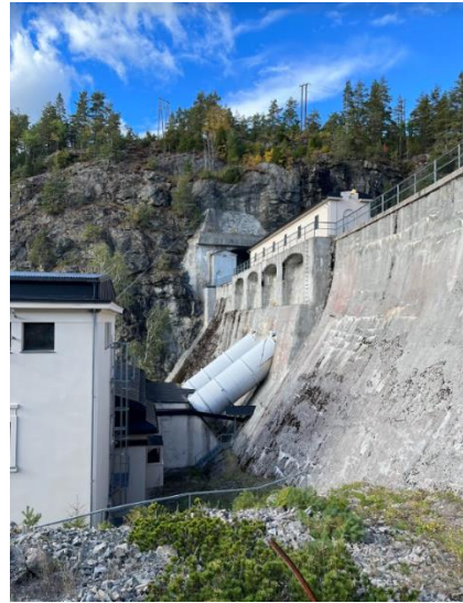
Figur 6. Demningen ved Brekke. Foto Stian Røed (2022).
