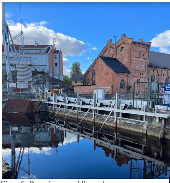
Figur 5. Demningen ved Svanedammen. Vanninntak til passasje som sikrer vannstrøm nedstrøms anleggsområdet til ny demning sees til venstre i bildet. Foto av Stian Røed (2022).
