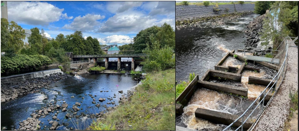
Figur 2. Vandringshinder og laksetrapp ved Porsnes. Foto av Stian Røed (2022)
