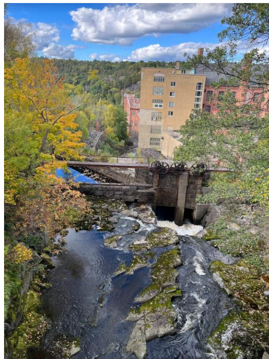
Figur 4. Demningen ved Deledammen sett ovenfra. Foto Stian Røed (2022).
